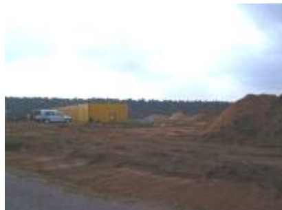
Erschließungsarbeiten im Baugebiet
